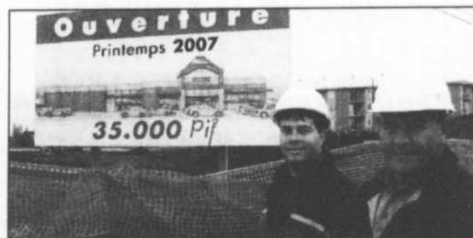
Métro St-Grégoire inaugurera sa nouvelle bâtisse en mars prochain. On voit ici François Pépin et Luc Vigneault, copropriétaires, devant le chantier. Photo Le Courrier Sud
