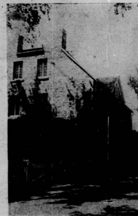
Voici un autre souvenir historique. Cet édifice des environs du Fort et aux lignes austères servait d'hôpital à la dernière garnison anglaise.
