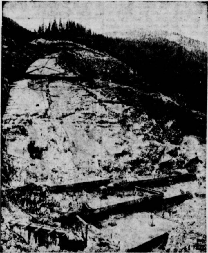
Les immenses blocs de béton que l'on voit au pied de la montagne ne sont que les fondations des bureaux de l'entreprise qui doit mener à bonne fin, d'ici 1953, la construction du gros barrage Hungry Horse, près de Columbia-Falls, Montana. Ce barrage sera le troisième en hauteur et le quatrième en largeur de tous les barrages du monde. Il atteindra le niveau du pont de bois que l'on peut voir, tout en haut, sur la photo.
