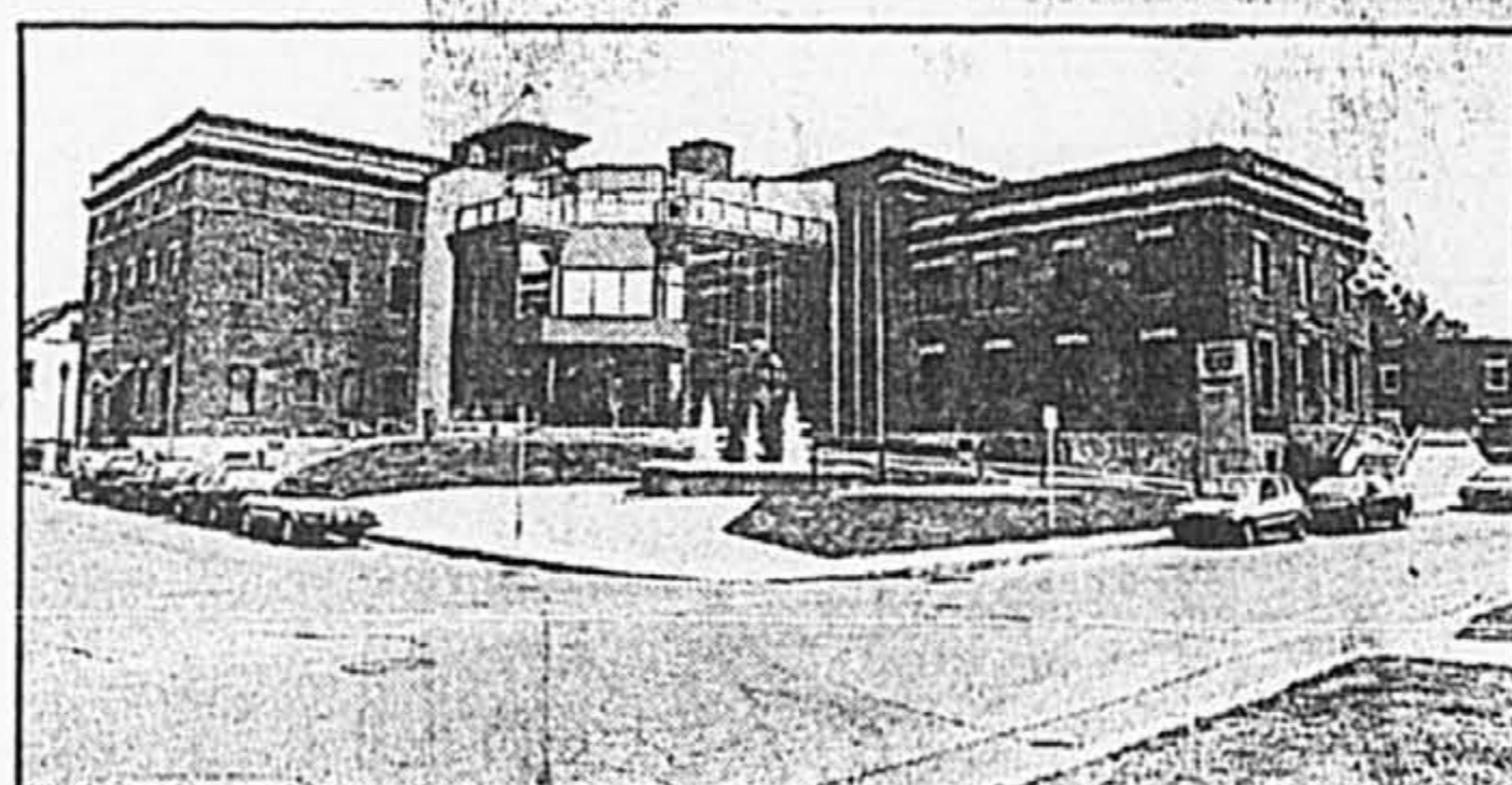
Montage montrant l'hôtel de ville avant et après les récents travaux.
