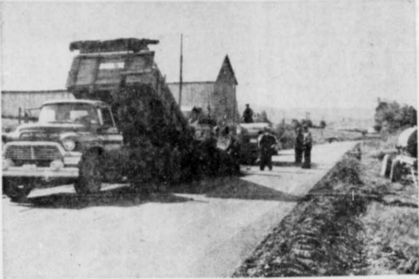
Pavage. — Cette photo fut prise aux travaux de pavage effectués par la firme Modern Paving, sur la route menant de St-Jacques de Leeds à St-Gilles, sur le chemin de Craig. Une longueur de cinq milles et demi de pavage sera faite sous la direction des contremaîtres, MM. Gérard Bergeron et Lucien Cayer. (Photo La Tribune, par le Studio Gagnon, East Broughton)
