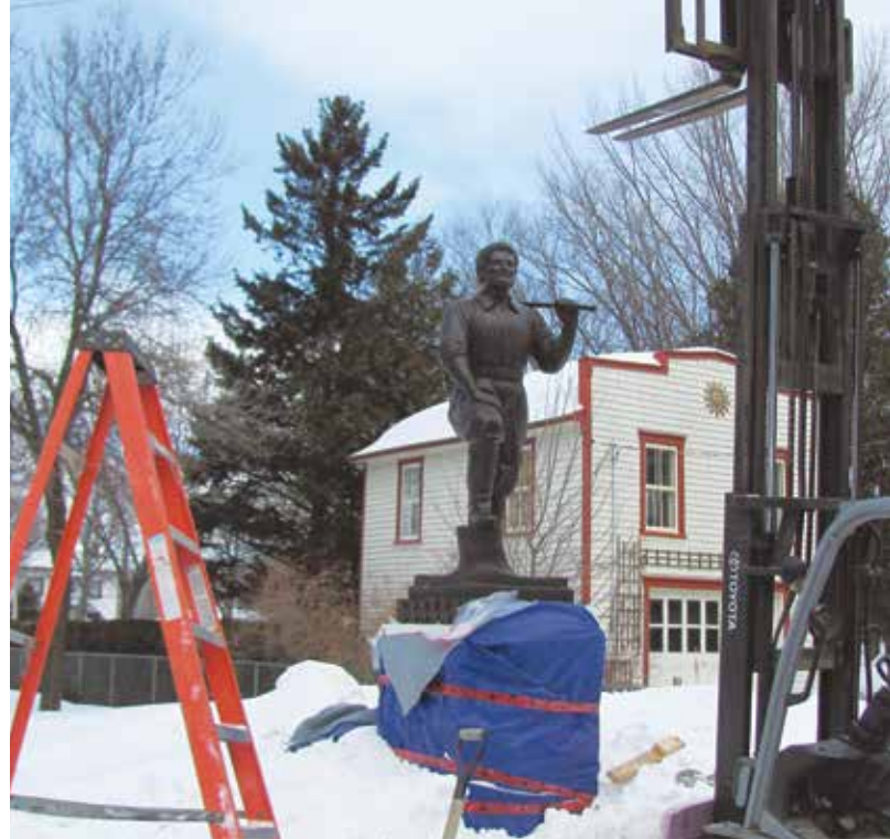
Chantier de réaménagement du monument Guillaume-Couture © CCNQ ; photographe : Jean-Philippe Servant
