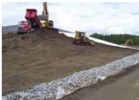
Le site en cours de restauration
