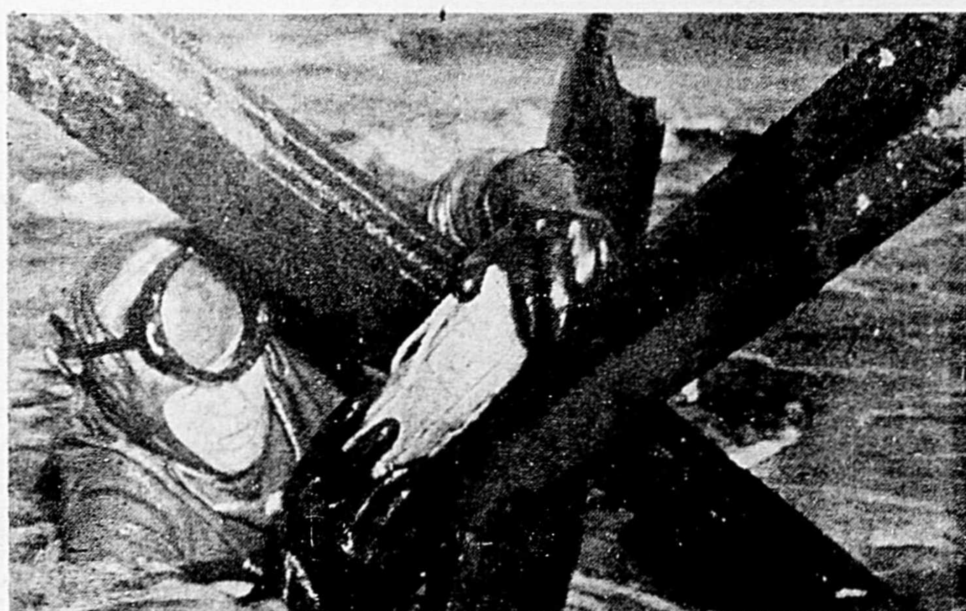
Parvenu silencieusement près des ouvrages de défense ennemis, cet homme-grenouille fixe sa charge de dynamite à un trépied de fer constitué par des rails de chemin de fer soudés.
