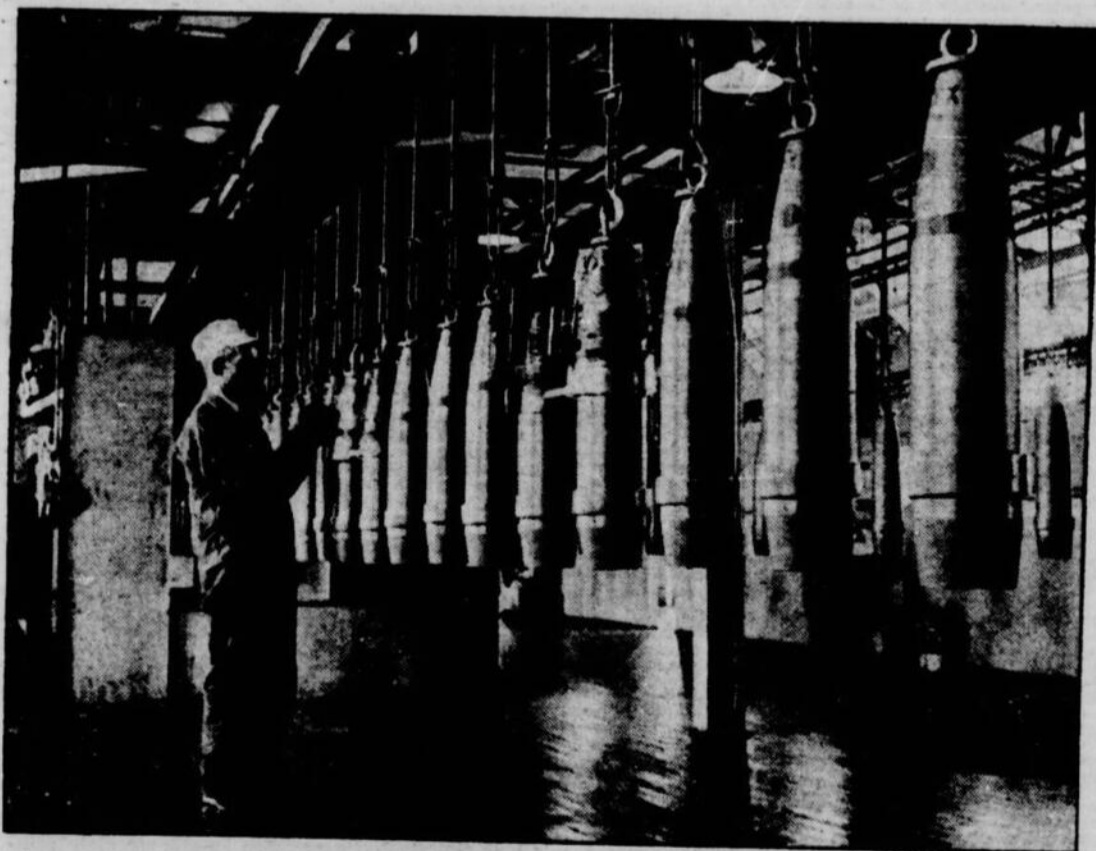
Suspendues comme les carcasses de boeufs dans les grands abattoirs de Chicago, ces énormes douilles de bombes glissent en rang sur le rail sans fin, en route pour la chambre de peinture où elles ne s'arrêteront même pas. Elles ne feront qu'y passer, mais grâce à l'emploi de pistolets à air comprimé, elles en sortiront protégées contre la rouille par une légère couche de peinture. Cette photo a été prise dans une usine canadienne.
