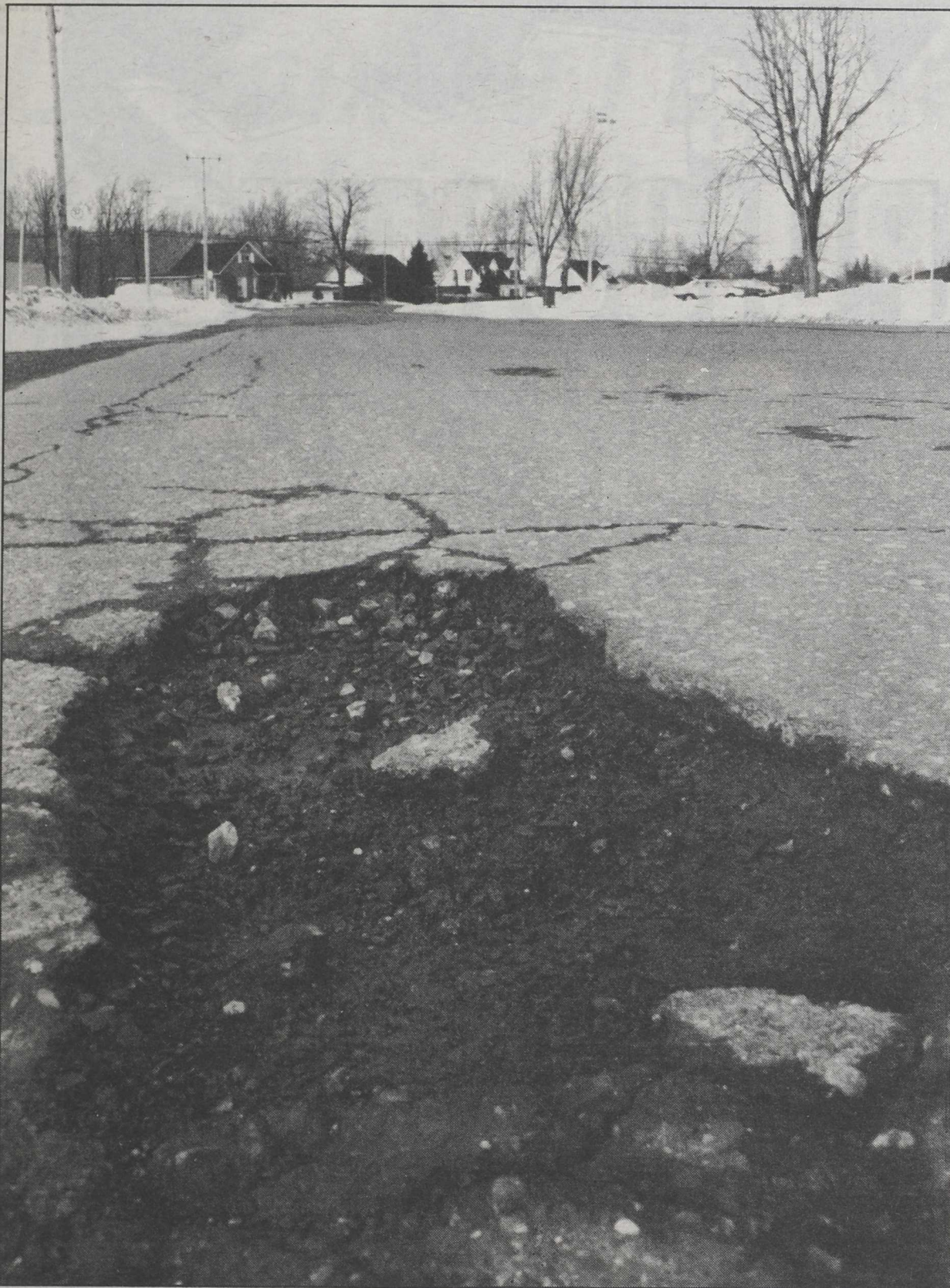
l'hiver 1988-89 s'avère particulièrement difficile pour le réseau routier. Les automobilistes doivent demeurer vigilant pour éviter les écueils, comme cette profonde ornière qui s'est formée sur l'avenue Le Corbusier. photo Michel Paquette
