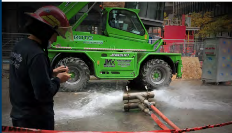
Supervision d'un test d'écoulement
