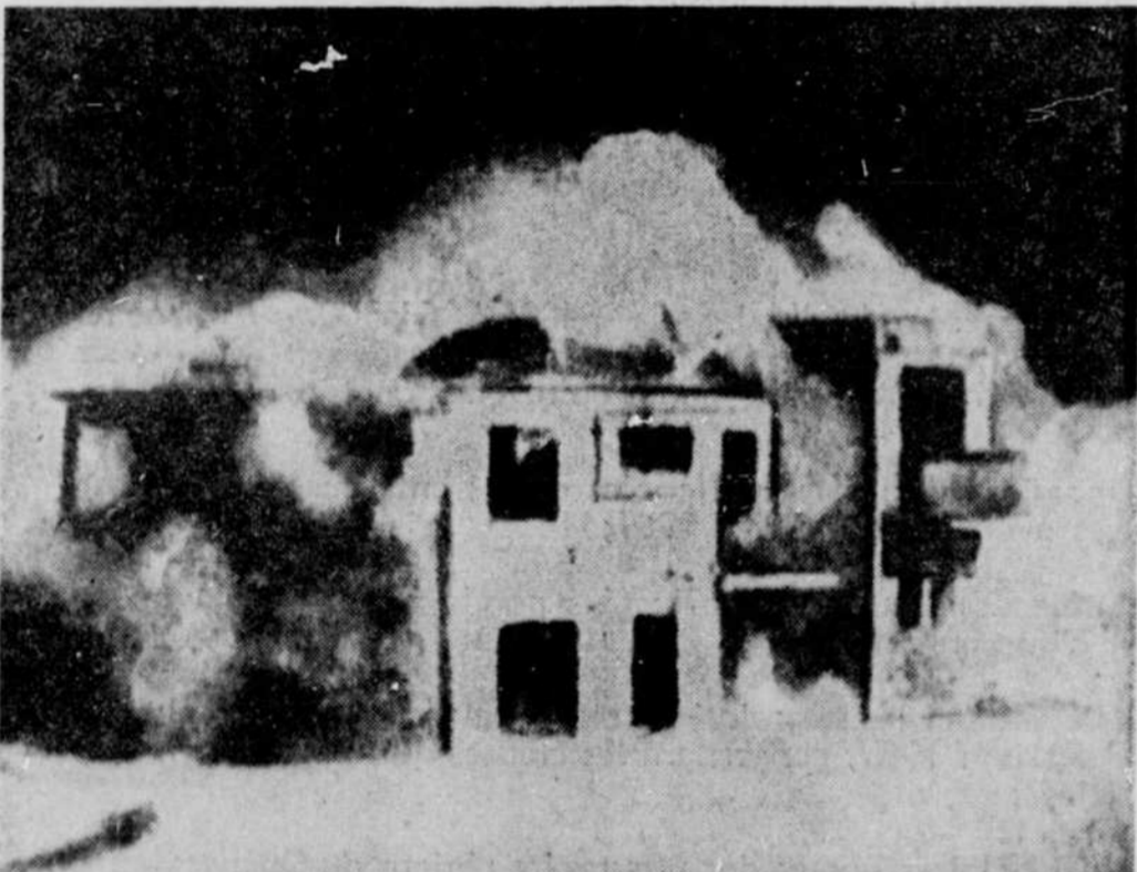
● TOKYO — Cette photo d'une maison en briques détruite par la troisième explosion nucléaire de la Chine rouge fait partie d'un film réalisé par les autorités communistes. Ce film sera projeté par une station de télévision du Japon. (Radiotéléphoto U.P.I.)
