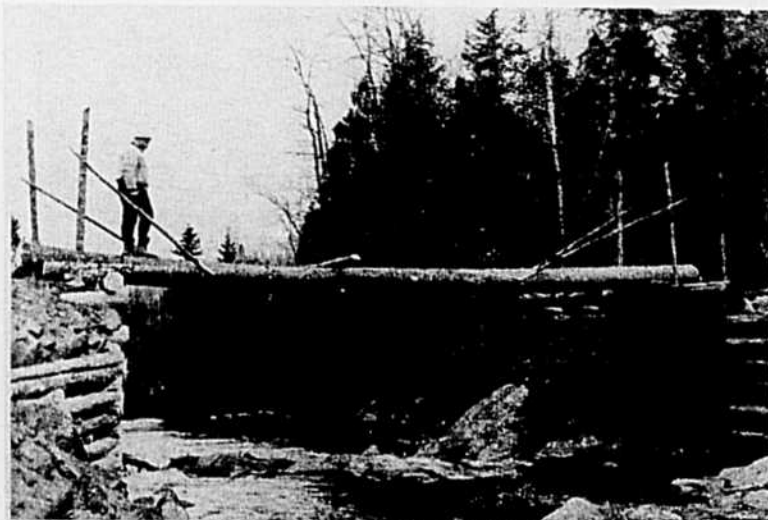
M. Lionel Milliard traverse le pont qu'il a construit avec les hommes qui ont profité du service de reclassement du gouvernement du Québec.
