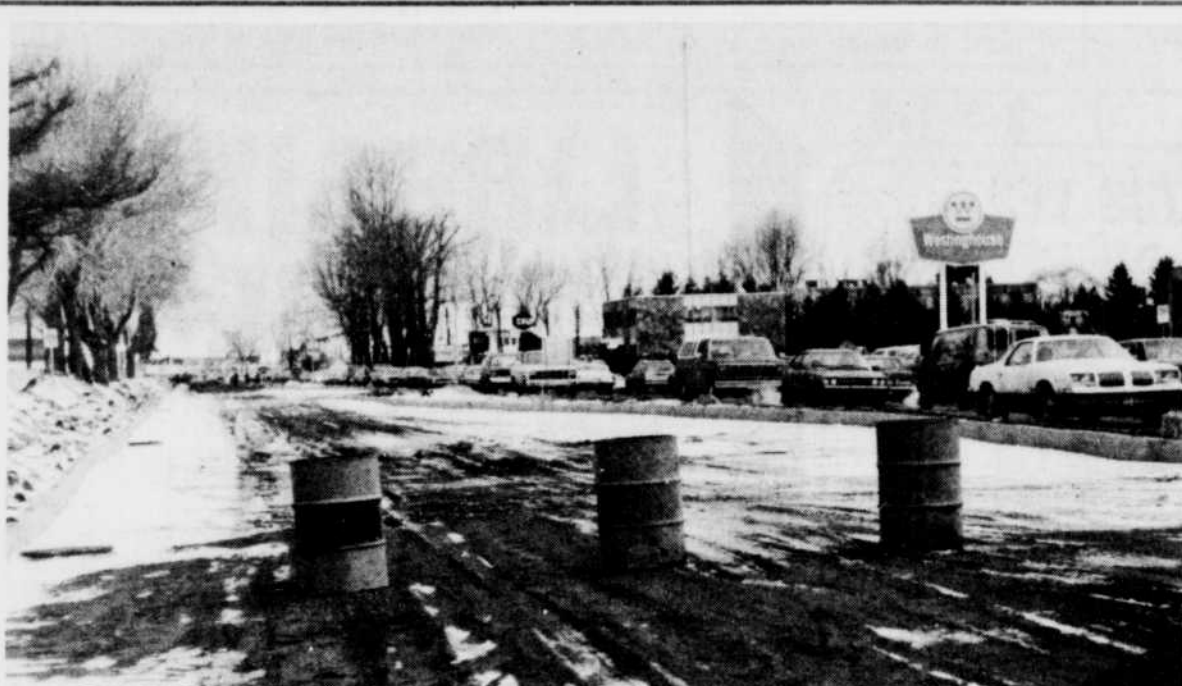
Le conseil municipal devra décider lundi si la voie sud de la partie du boulevard Royal en construction restera fermée pour l'hiver ou si les automobilistes pourront l'emprunter, même sur fond de gravier.
