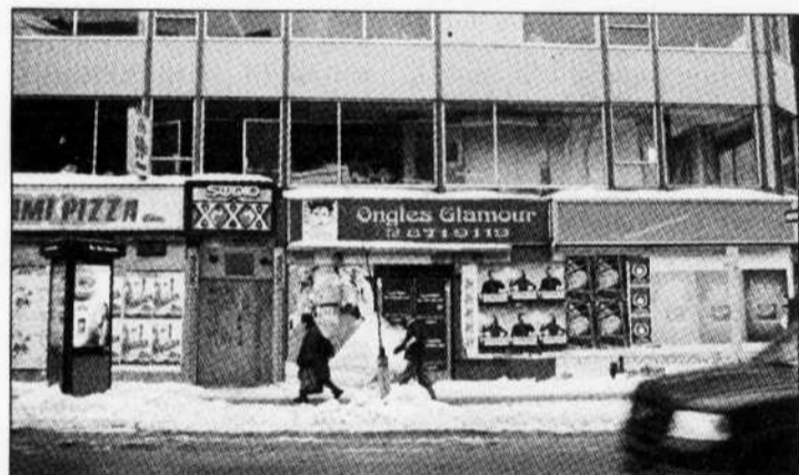
Bâtiment condamné du Red Light avant sa démolition
