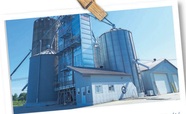
Le centre de grains actuels de la Ferme Bogemans a été reconstruit à neuf à la suite d'un effondrement en 2013.
