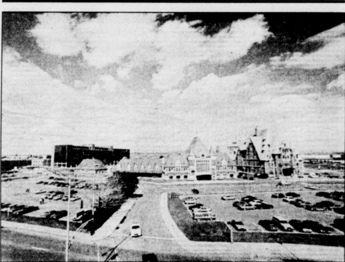
Les terrains supportant la gare intermodale (au centre) et le palais de justice (à gauche), sont essentiellement constitués de remblais d'une profondeur de 20 pieds environ.
