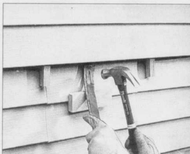
PHOTO B: Piquez les clous à tige spiralee dans la bande de clouage et enfoncez-les avec un levier plat et un marteau.
