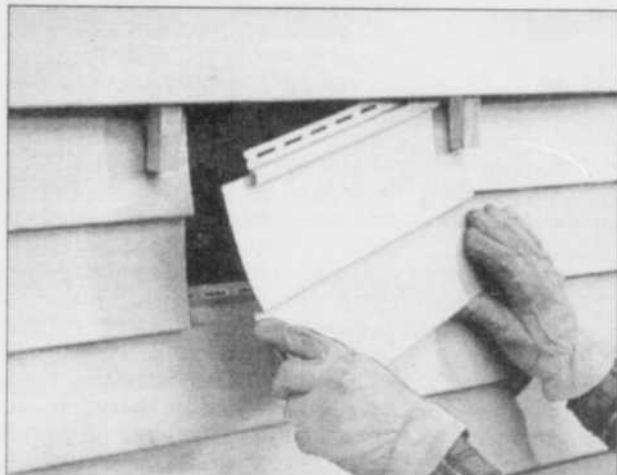
PHOTO A: Déboîtez les joints et découpez la section endommagée puis la pièce de remplacement, raccourcissez sa bande de clouage et glissez la pièce de remplacement en place.
