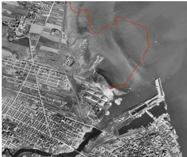
Vue aérienne du secteur de la baie de Beauport en 1948 avant l'agrandissement du Port.
