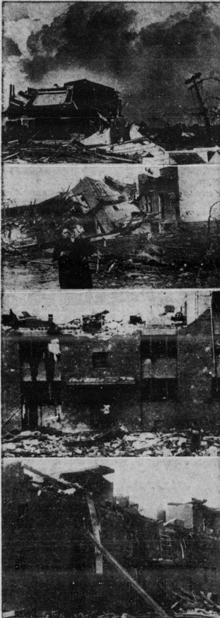
APRES LE PASSAGE DE LA TORNADO AU MASSACHUSETTS. — La tornade qui a frappé 11 localités de l'Etat du Massachusetts, mardi, à l'heure du souper, n'a laissé après elle que ruines et dégâts, comme en font preuve les photos ci-dessus. De haut en bas, première photo, des nuages noirs forment un arrière-plan sinistre au-dessus de cette maison au toit arraché par le vent à Shrewsbury. Deuxième photo, Mme Alice O'Donnell, de Worcester, pleure la destruction de sa demeure tandis qu'une voisine tente de la reconforter. Troisième photo, 80 personnes ont subi des blessures dans cette conciergerie de Worcester ravagée par l'ouragan. Quatrième photo, ce qui restait d'une autre conciergerie émise sur le passage de la tornade.
