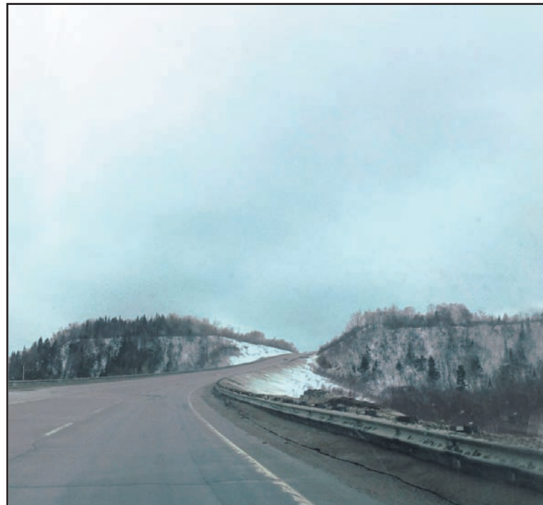
La chaussée de la côte à Hickey fera l'objet de travaux d'ici les deux prochaines années. Photo Journal Haute-Côte-Nord
