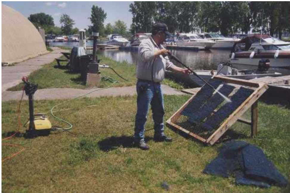
Photo 4. Technique de nettoyage des parpaings au moyen d'un support et d'un pulvérisateur à pression, partie amont des rapides de Lachine, printemps 2002.
