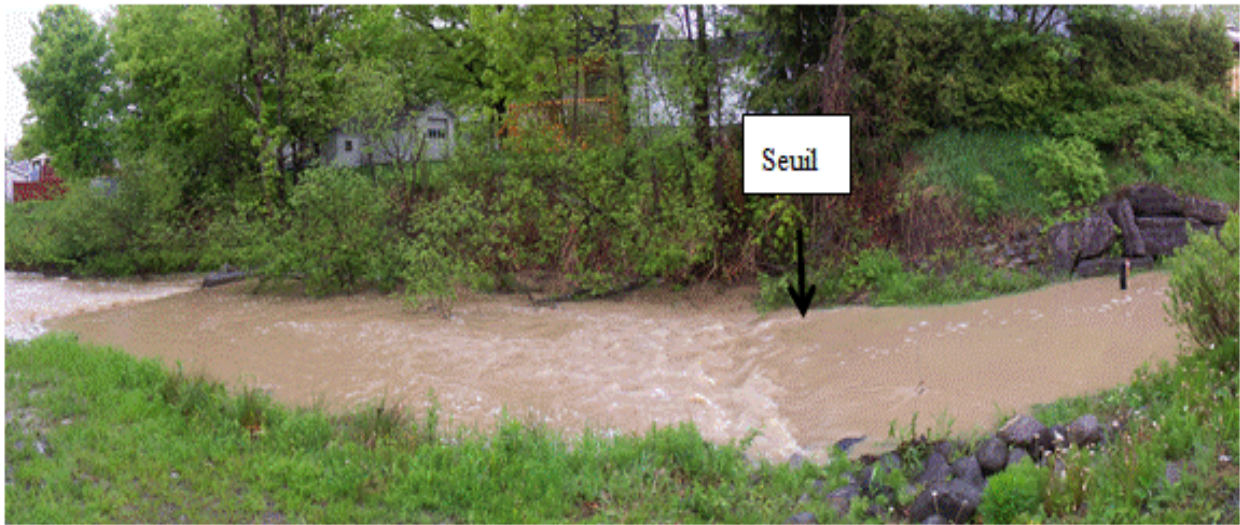
Figure 27 : Bassin de sédimentation en amont du lac en temps de pluie (28 juin 2013)
