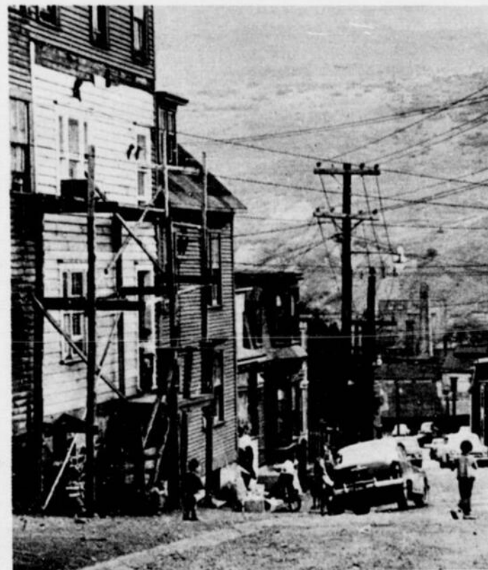
UNE RUE DE SAINT-JEAN, Terre-Neuve. Par ses établissements portuaires, ses côtes raides, ses maisons au charme ancien, ses établissements commerciaux, cette ville offre un intérêt qu'on ne rencontre nulle part ailleurs. (Photos ARAU) (Suite à la 14e page)
