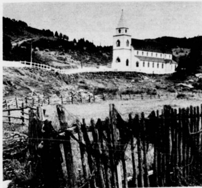
CETTE EGLISE BLANCHE de Portigal Cove se répète à des centaines d'exemplaires dans toute l'île de Terre-Neuve.
