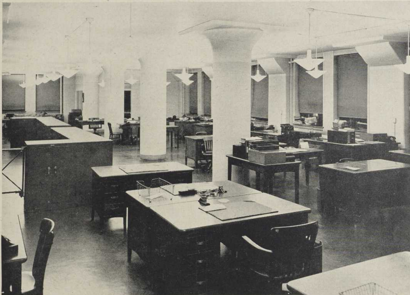
L'éclairage des bureaux par les appareils ordinaires disposés en nombre requis pour donner une lumière régulière par tout le bureau.
