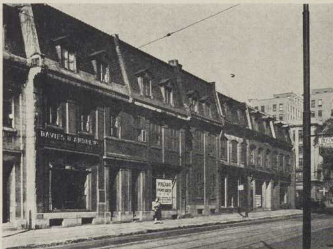
Il y a deux ans, les maisons qui occupaient le site actuel de l'immeuble Shawinigan.
