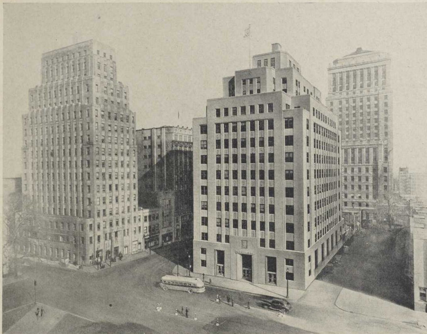
La construction est terminée. A gauche du nouvel immeuble de la Shawinigan, on voit l'édifice de la C.I.L., et en arrière celui de la Compagnie de téléphone Bell.
