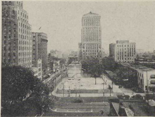
Une fois les travaux de démolition terminés.
