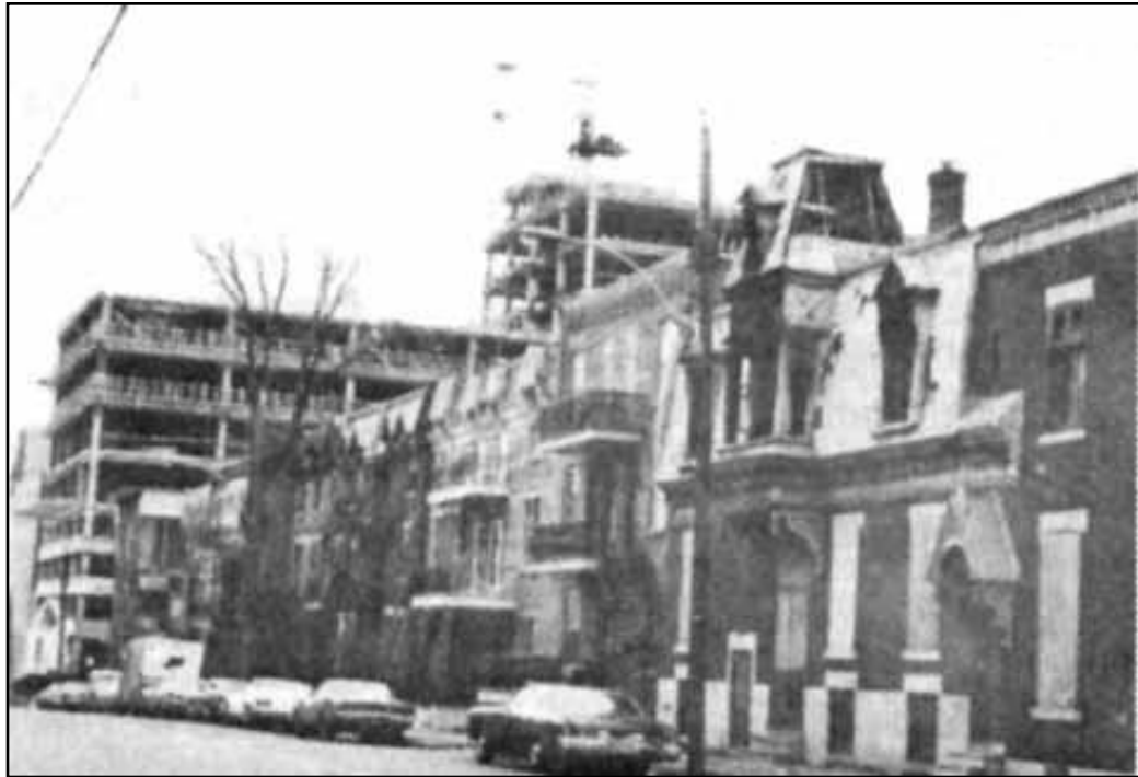
Tous les moyens sont bons pour faire passer la rénovation urbaine, y compris les feux.
