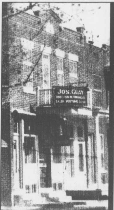
L'établissement commercial de Joseph (Jos) Guay, rue Saint-André, au sud de Saint-Pierre, à Terrebonne. Le salon funéraire était à l'étage avec entrée de l'étage à gauche sur la photo. (Photo : collection Aimé Despatis, CRAL)
