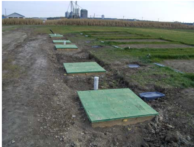
Figure M.12 : Vue générale du site expérimental.
