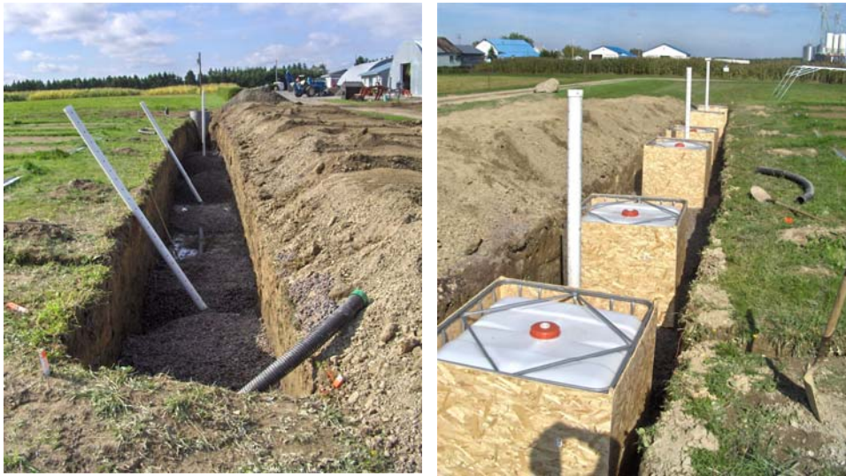
Figure M.6 : Installation des regards et des réservoirs
