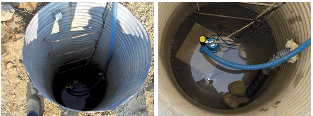
Figure M.9 : Accès au puits et installation de la pompe submersible.
