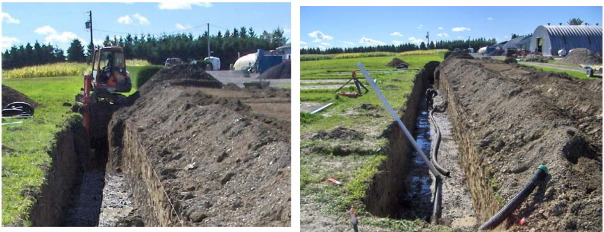
Figure M.5 : Excavation de la tranchée et aménagement des drains d'évacuation.
