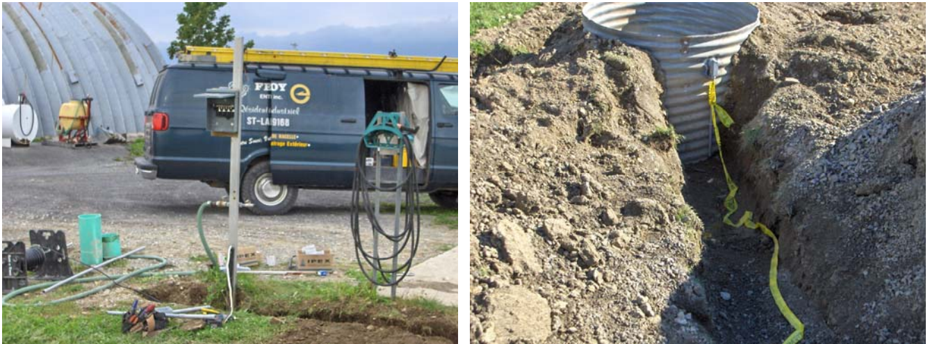
Figure M.8 : Électrification de la station de pompage.
