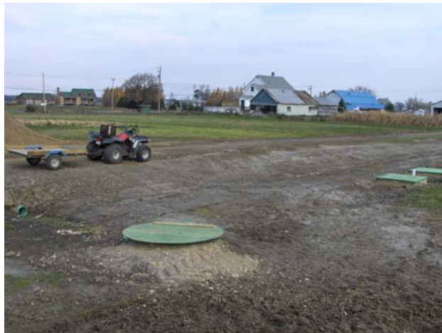
Figure M.13 : Vue générale du site expérimental
