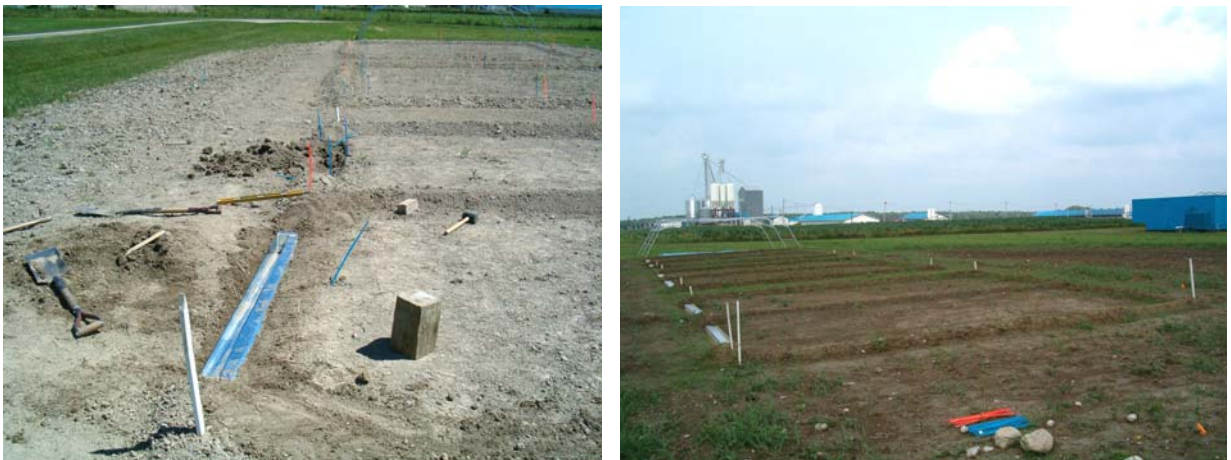
Figure M.3 : Installation des gouttières de métal en aval des parcelles.
