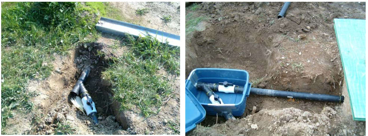
Figure M.11 : Installation du circuit de contournement bi-valves
