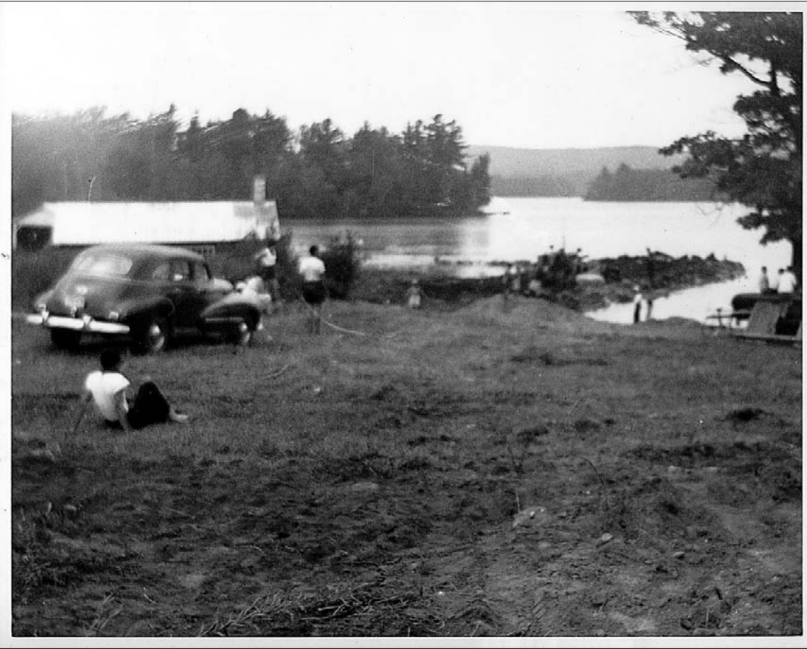
Commencement des travaux de construction de la plage effectués par M. Maurice Rainville en 1949.
