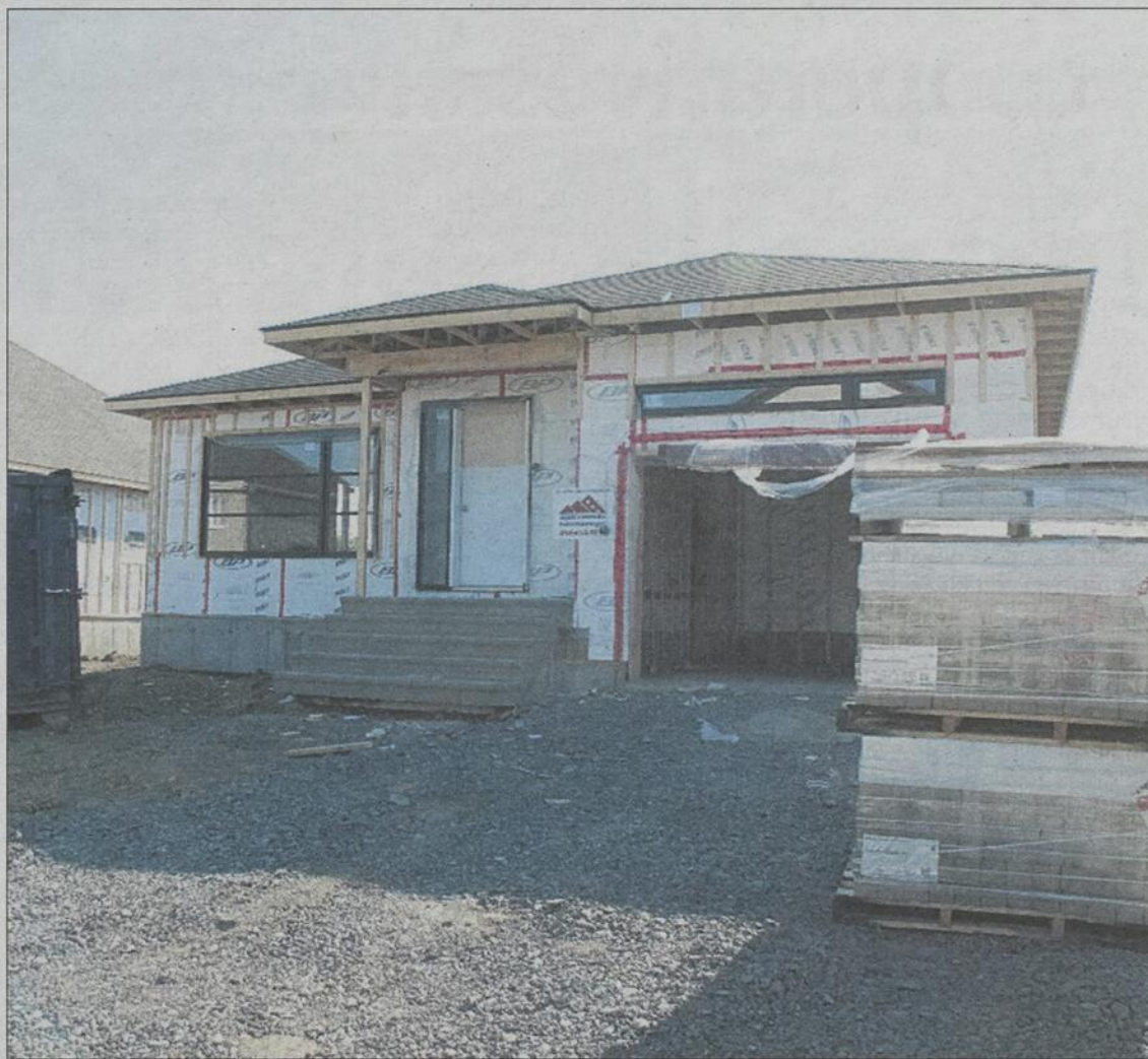
À l'inverse de la tendance provinciale, Saint-Jean-sur-Richelieu a dépassé le nombre de mises en chantier pour les six premiers mois de l'année, comparativement à la même période l'an dernier.
