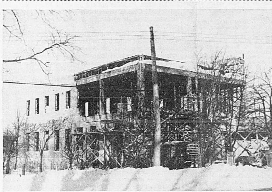
La construction du nouvel immeuble de la Compagnie de Téléphone Bell du Canada à St-Jérôme va bon train, comme l'indique cette récente photo. Il s'agit d'une bâtisse en brique, de deux étages avec façade de pierre et sous-sol, qui servira à loger le bureau d'affaires et le nouveau central automatique. Selon les prévisions de M. L.-W. Ball, gérant local de la compagnie Bell, le téléphone à cadran sera un fait accompli dans notre ville dès l'hiver prochain.
