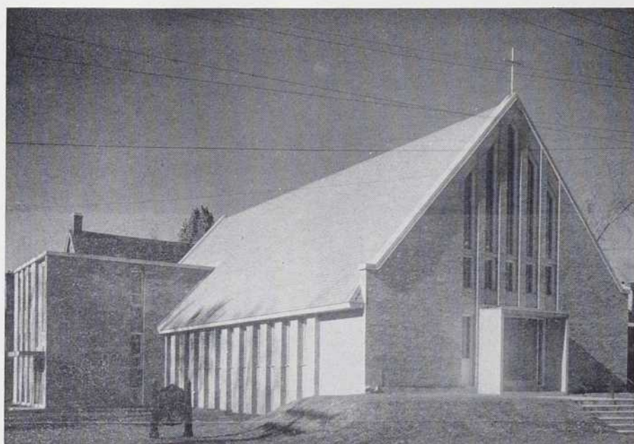
Deux vues de l'église. A l'arrière se trouve la seconde partie de l'édifice qui abrite l'étude du ministre et la salle de réunion des groupements paroissiaux.
