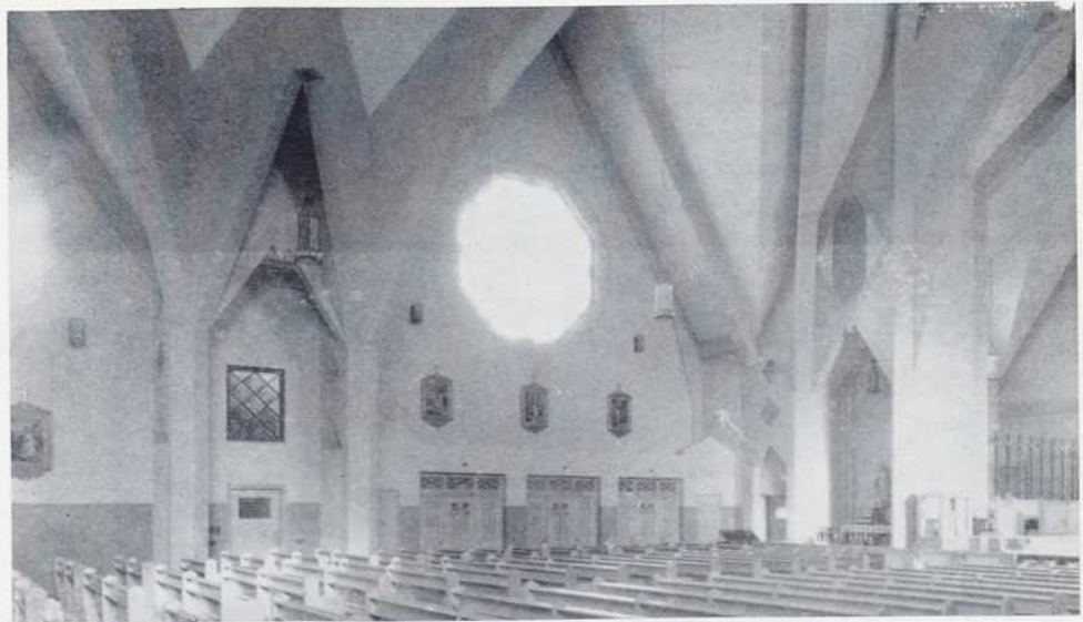
Vue sur le transept, regardant les confessionnaux. L'alcove sert à loger l'autel secondaire. Une grille sépare le chœur de son bas-côté.
