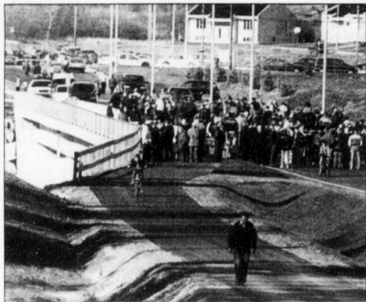
NOUVEAU PONT - Plusieurs représentants des autorités municipales et religieuses et des citoyens des quartiers St-Antoine et St-Paul, ont pris part, hier après-midi, à l'inauguration du nouveau pont sur la rivière Chicoutimi, à la hauteur
