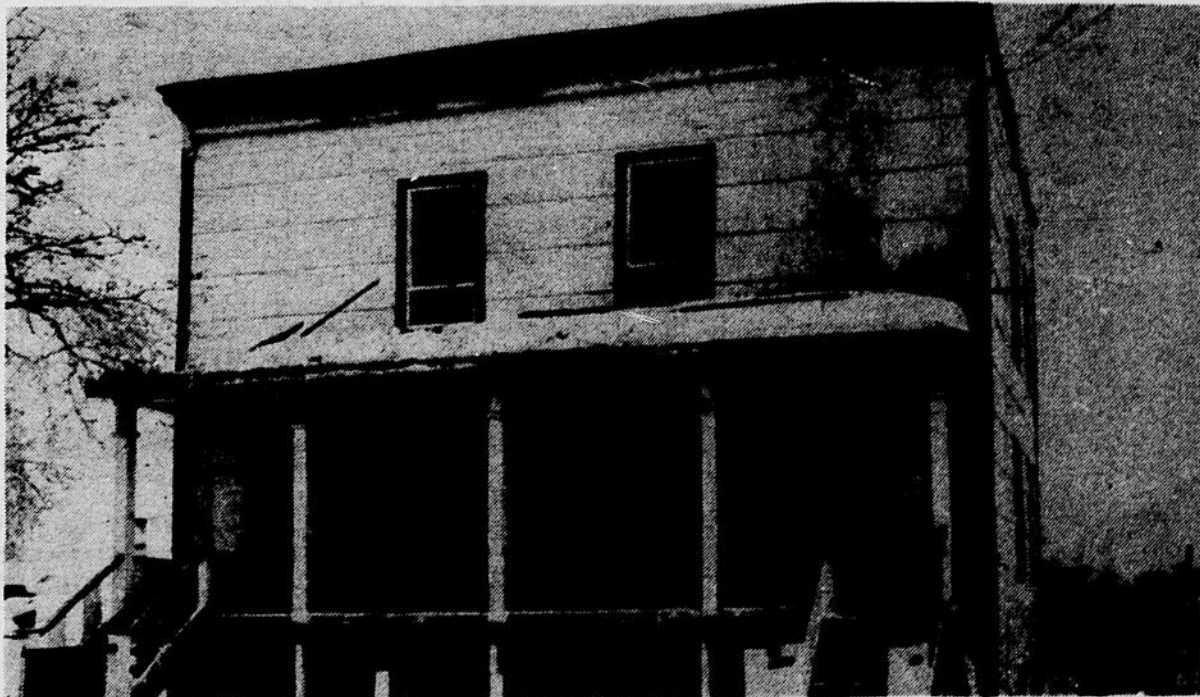
INCENDIE — Seuls les quatre murs de cette maison multi-familiale sont demeurés debout, à l'issue d'un incendie survenu mercredi soir, à La Baie.
