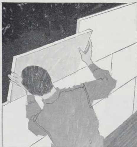
2. Pressez Styrofoam en place.
