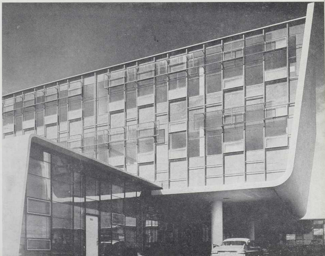
Détail de l'entrée.
