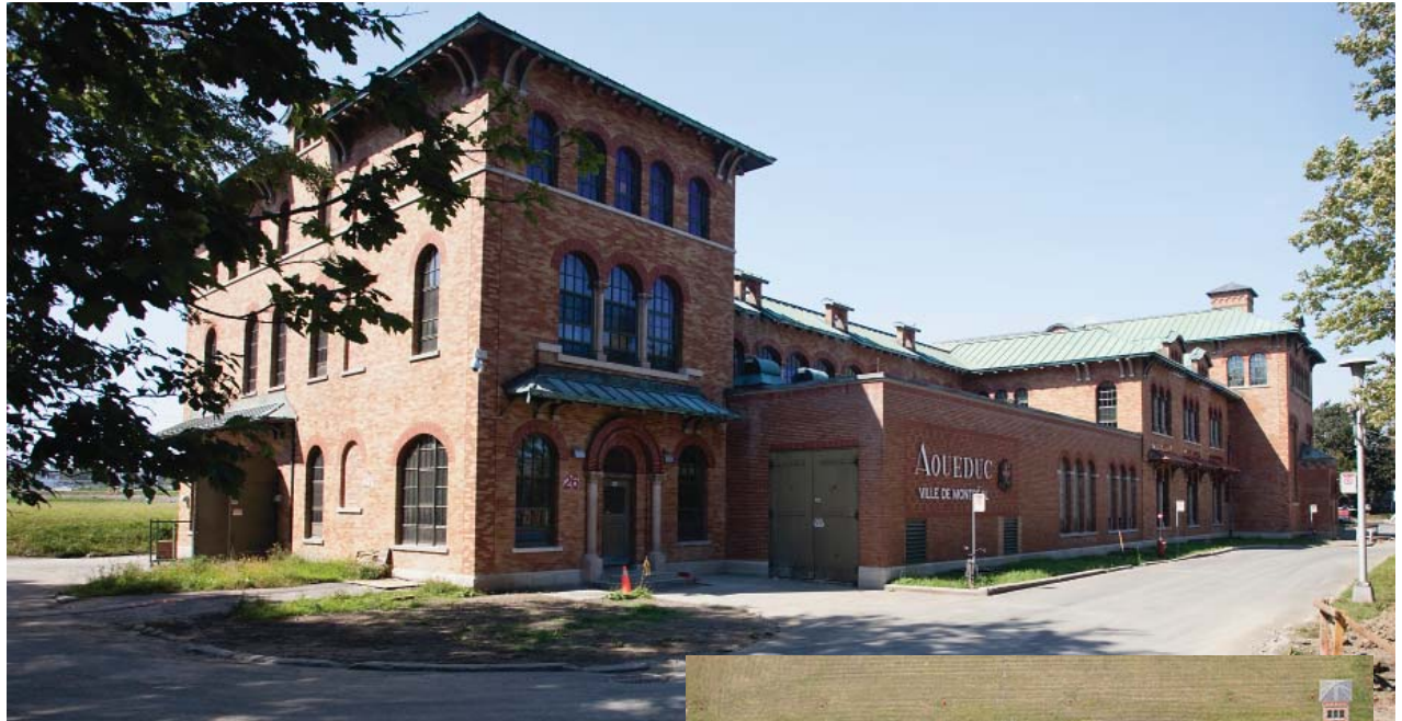
Usine de production d'eau potable Atwater
