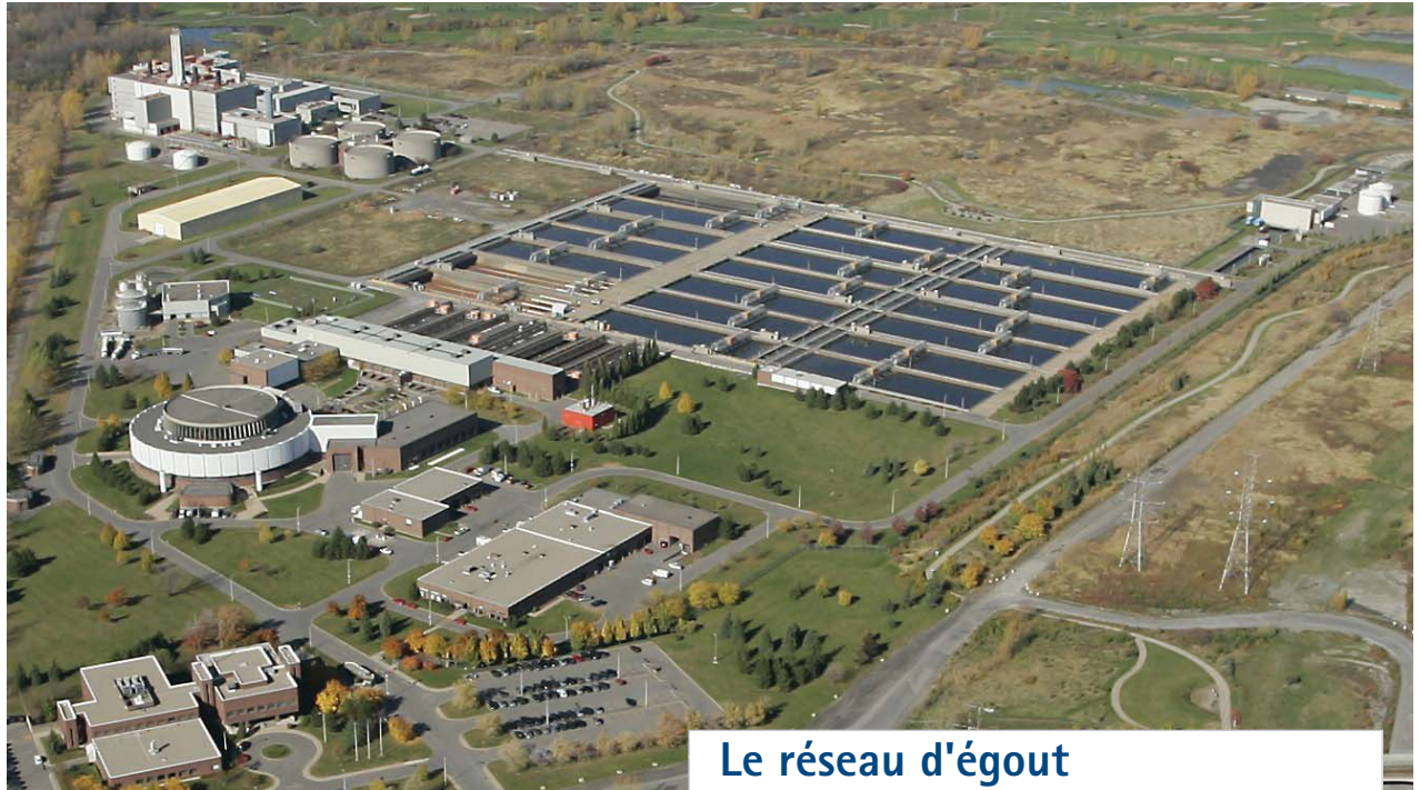
Station d'épuration des eaux usées Jean-R. Marcotte
