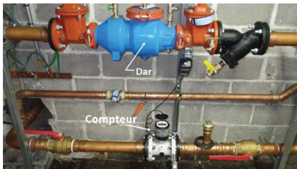
Exemple d'installation d'un compteur magnétique 3" avec Dar
