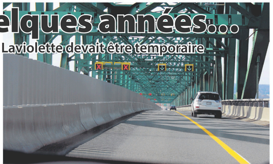
La ligne continue sur le Pont Laviolette interdit les dépassements entre chaque voie.
