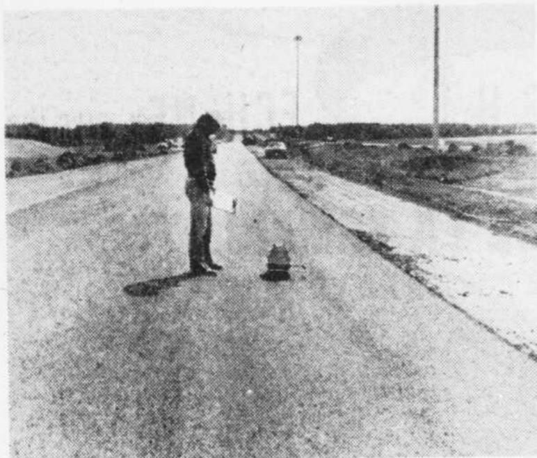
Un employé du ministère des Transports vérifiant la dureté de l'asphalte posé sur l'autoroute de la Beauce, entre Saint-Maxime de Scott et Sainte-Marie.
