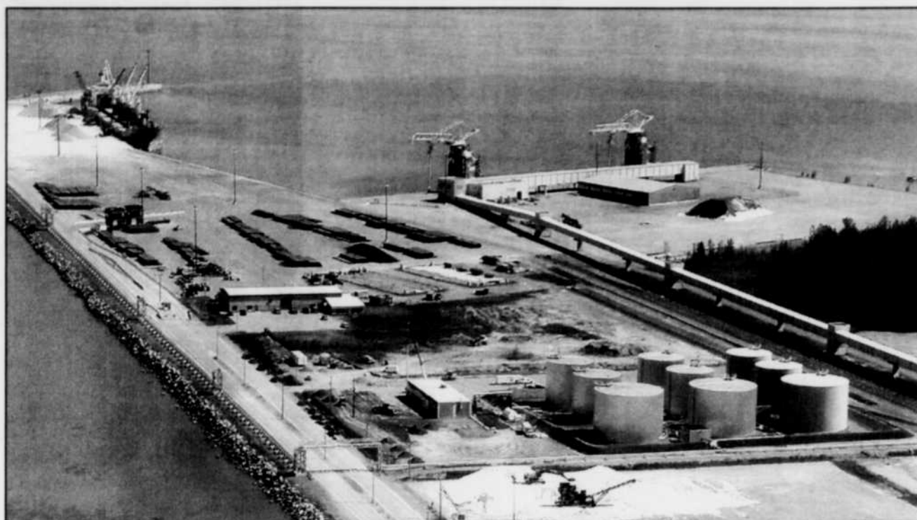
Une vue aérienne des nouvelles installations de manutention et d'entreposage de vrac liquide à l'entrée du port de Bécancour. Ces installations comprenant notamment neuf réservoirs et un petit bâtiment ont été inaugurées cette semaine.
