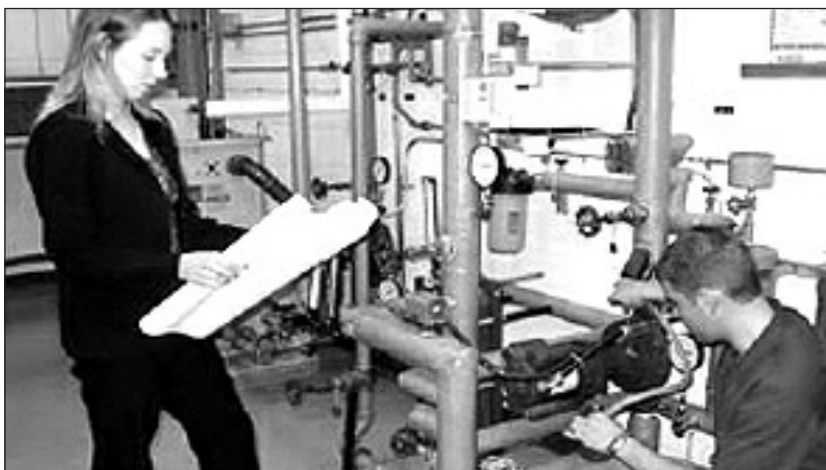
Des étudiants de Technologie de la mécanique du bâtiment, en stage.
