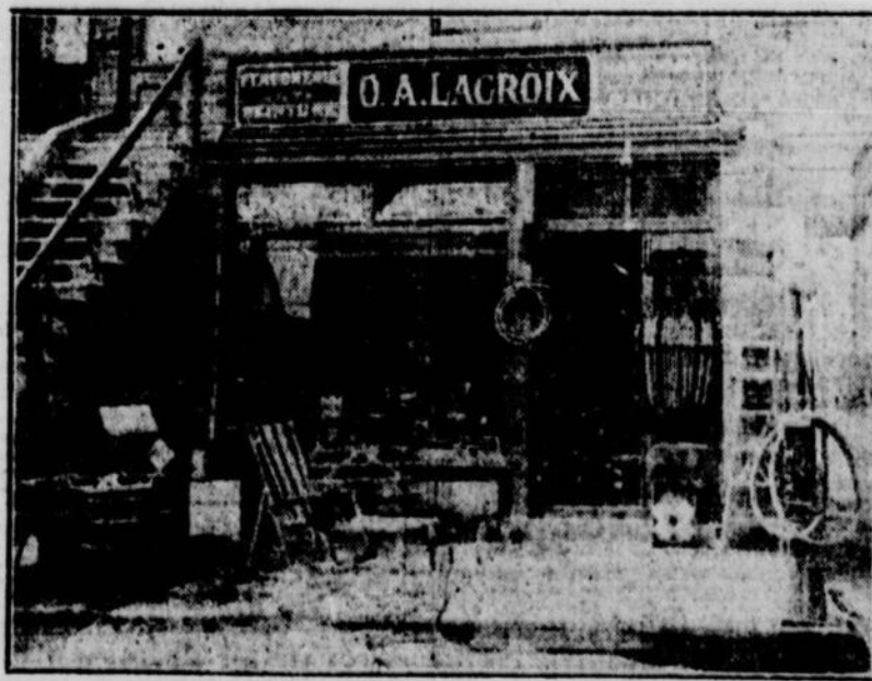
Le joli établissement de quincaillerie de M. O.-A. LACROIX, situé au No. 2226 rue St-Denis.
