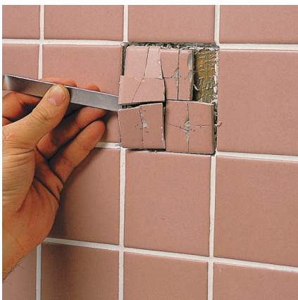
D. Enlevez le coulis des joints entourant le carreau, brisez le carreau et retirez-le à l'aide d'un marteau et d'un ciseau.
