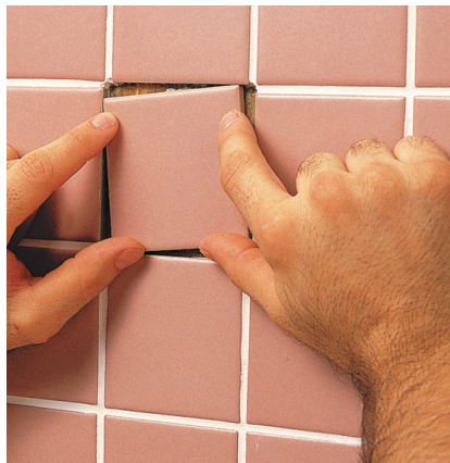
E. Appliquez de l'adhésif à l'arrière du nouveau carreau, logez-le dans l'ouverture et pressez-le fermement contre le mur. Laissez sécher pendant 24 heures.
