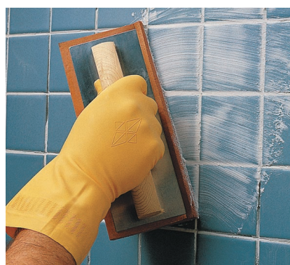
B. Étalez le coulis sur les carreaux et faites-le pénétrer dans tous les joints.
