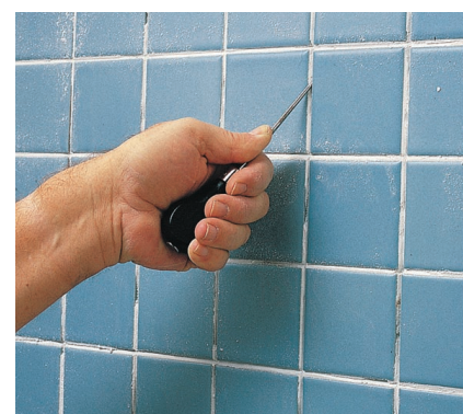
A. Grattez le vieux coulis au moyen d'une alène ou d'un couteau universel.
