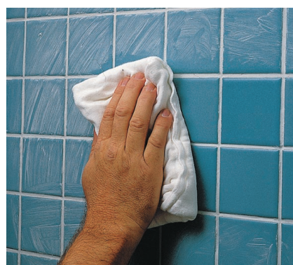
C. Frottez le résidu de coulis et polissez les carreaux avec un linge doux et sec.
