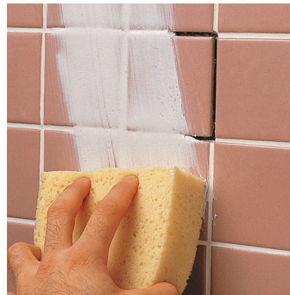
F. Appliquez le coulis prémélangé au moyen d'une éponge ou d'un aplanissoir à coulis.
