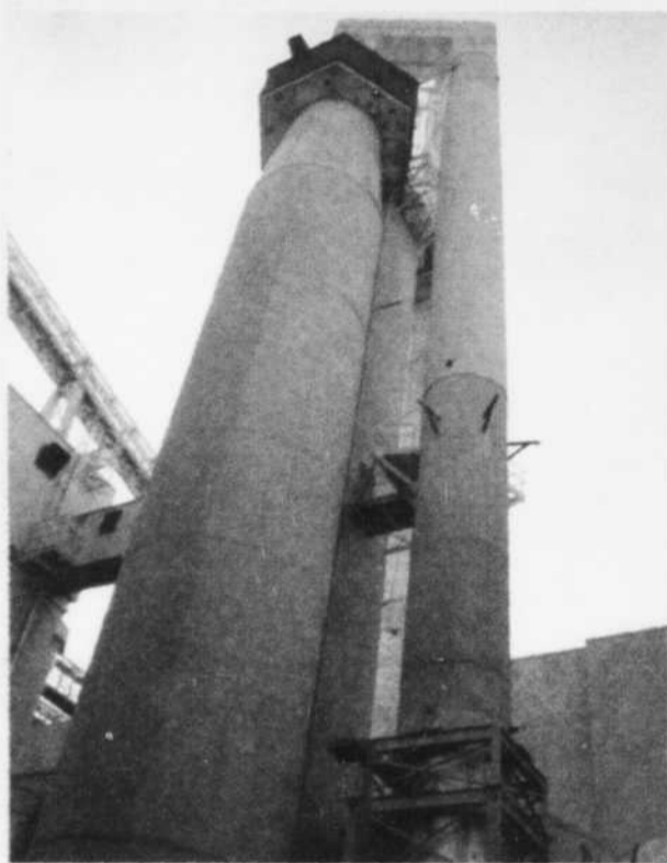
La nouvelle section de la cheminée installée avec succès.
