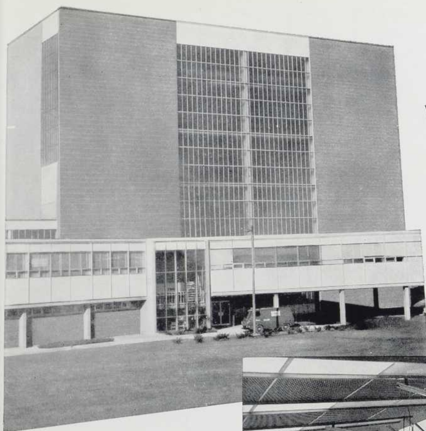
Installation standard à la station génératrice de Lakeview pour l'Hydro de l'Ontario.
