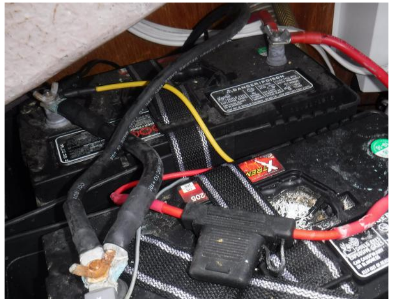
Montage Acide / Plomb décharge profonde.
