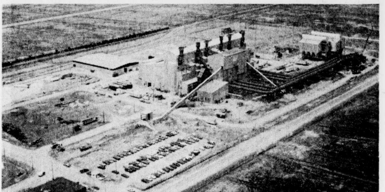
La plus récente addition au parc industriel de Béconcour est la toute nouvelle usine "Electro-metallurgie SKW Canada Ltée". D'une valeur de $50 millions, l'usine a trois haut-fourneaux produisant du ferro-silicium et du silicium métallique, utilisés dans les industries métallurgique et chimique, ainsi que dans la fabrication de l'aluminium, à travers le monde entier. 85% des actions de SKW-Canada appartiennent à SKW-Trostberg (Allemagne de l'Ouest) et 15% à la Cie A/S Ila og Lilleby Smelteværker de Trondheim en Norvège. SKW-Trostberg a actuellement en Allemagne de l'Ouest cinq usines en fonctionnement, qui fabriquent des produits carbo et pétrochimiques, des produits chimiques pour l'agriculture ainsi que pour la construction et l'industrie métallurgique, tels que le ferro-silicium et le silicium métallique. Le chiffre d'affaires approximatif de SKW-Trostberg était de $200 millions en 1975. Lorsqu'elle fonctionnera à plein rendement, l'usine produira environ 60,000 tonnes de ferro-silicium et de silicium métallique.
