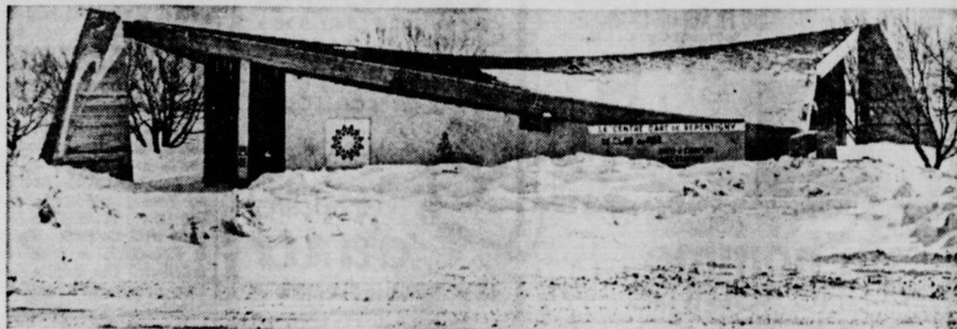
Le Centre d'art de Repentigny, devenu centre de loisirs pour les jeunes de la ville, est maintenant doté d'une toiture permanente qui a fait place à la grande toile qui servait de toit en été.
