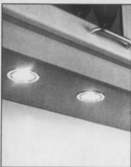
Ampoule au krypton sous les armoires, éclairage de tâches discret.
