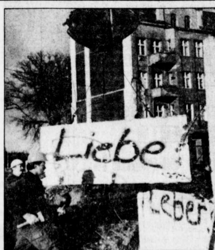
Des ouvriers ont enlevé, en fin de semaine, les derniers morceaux du mur de Berlin.
