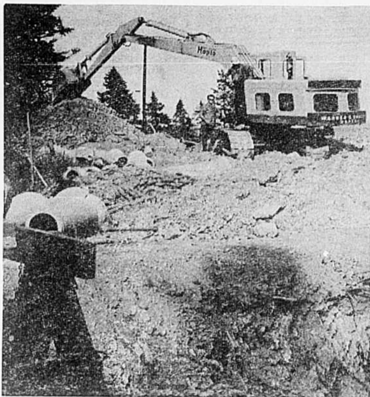
● c'est la construction domiciliaire qui nécessite ce déploiement de matériel lourd, rue du Domaine, à Rimouski...
