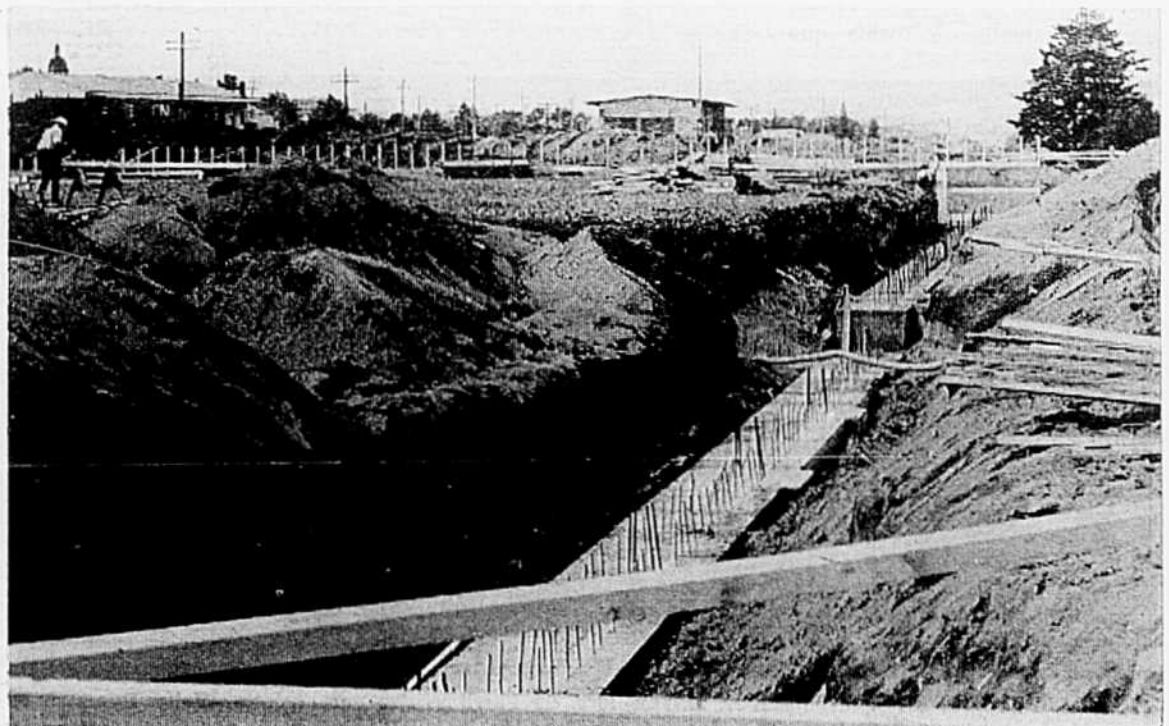
Après les travaux d'aqueduc et d'égoût, rue Des Chevaliers, qui débouche sur la rue Léonidas, au Parc Industriel, c'est la rue que la Ville construit pour accéder aux entrepôts L.R.D. et C. Bérubé.
